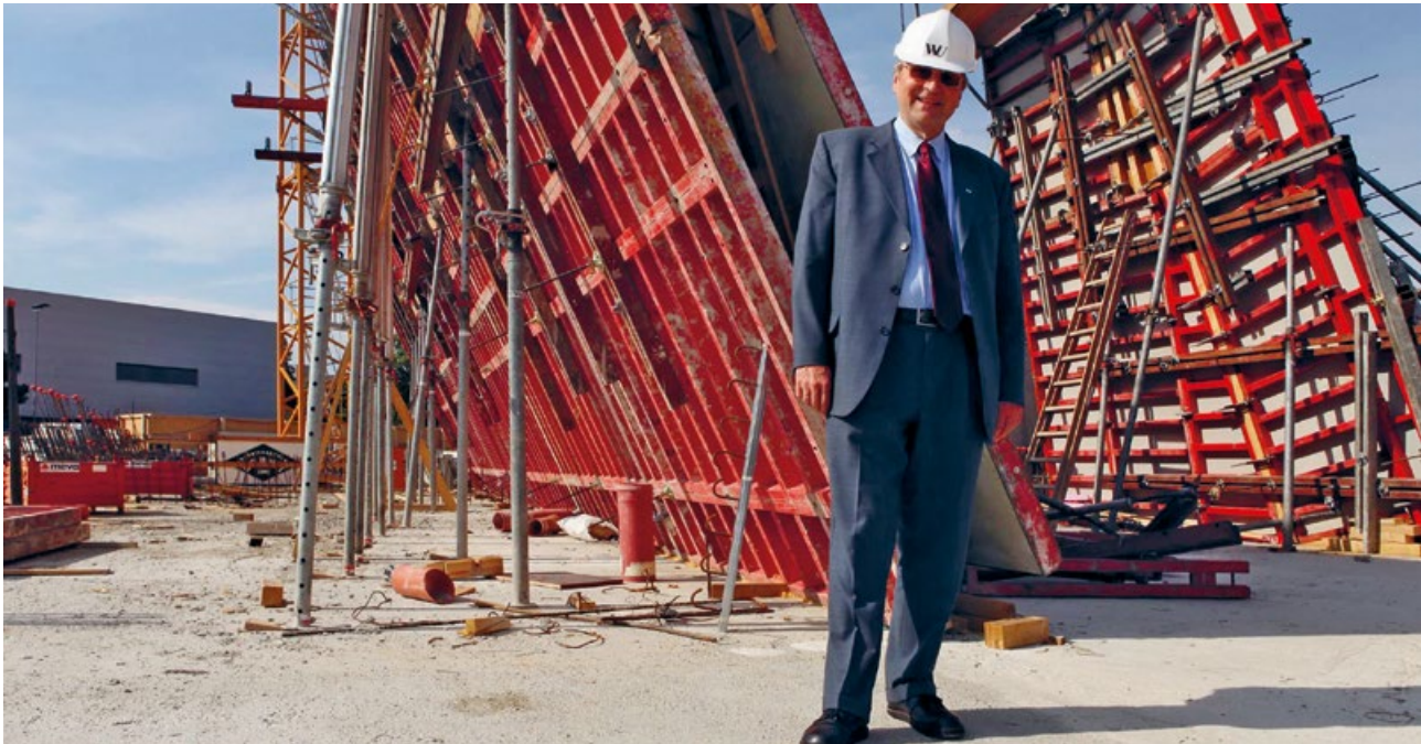
Das Aufziehen der ersten Schrägen des Library & Learning Center (LC)
